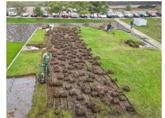
Figura 2. Ejemplo de un Tecnoles, suelo colocado sobre un techo de un edificio para hacer un jardín
